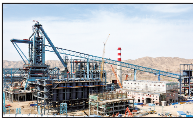
建设中的榆钢2800m³高炉
