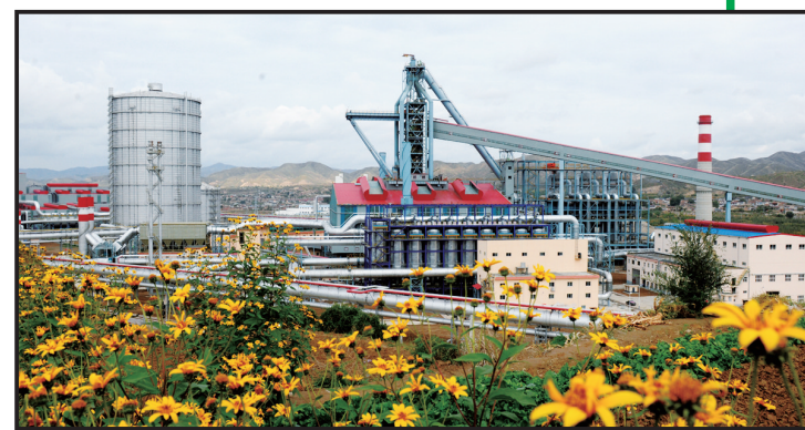
2012年9月28日,榆钢2800m³高炉点火开炉
