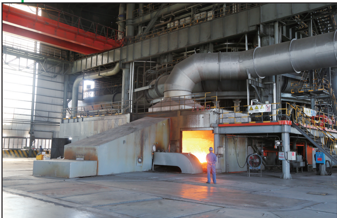
干净整洁的7号高炉出铁平台
