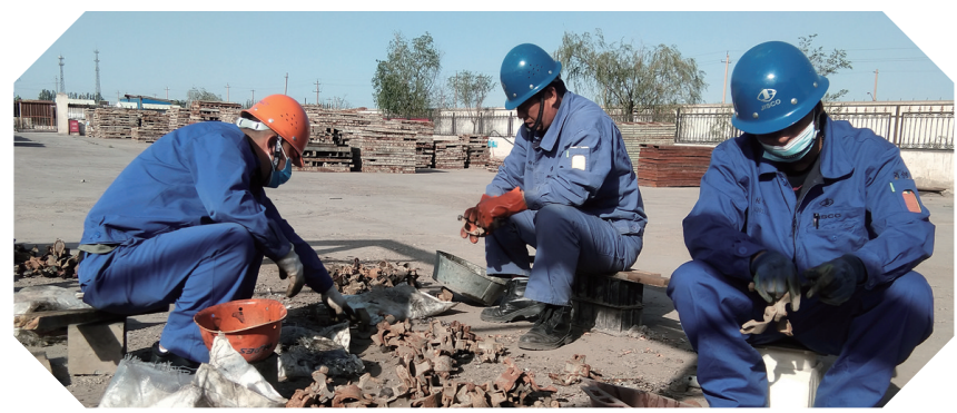
近期,筑鼎公司建安分公司针对施工现场周转料具紧张现状,迅速组织管理技术人员进行脚手架杆件修复,共修复扣件7000余个,节约采购成本2万余元。 杨清柳 摄
