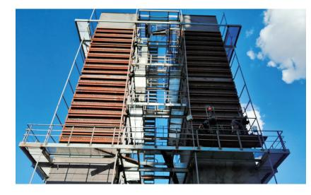
近日,宏兴股份公司焦化厂预冷塔安装工程按期完成。预冷塔投产运 行后,可对煤气中的焦油雾和蒸进一步净化收集,不仅能提高煤气净化脱 硫效率,降低设备能耗,还有利于提高化产品收率,降低废气中二氧化硫对 空气的污染。
