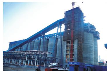
酒钢1、2号焦炉优化升级建设项目外部公辅系统焦煤输送改造分项,是信息自动化分公司宏联自控公司2022年初承接的综合类项目。针对项目建设内容多、施工难度较大的现状,该公司项目部严格落实安全生产工作要求,精心组织施工,确保施工期间安全、质量和进度全面可控。目前,项目部已经完成JS2和JS3转运站电气配管、电缆桥架安装、JS1转运站设备电机电缆接线、弱电外网机柜安装等工作。
