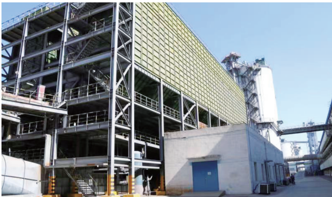
今年以来,东兴铝业公司创新建立净化区域物料输送设备自动化控制、设备状态监测系统模型,对8套物料输送系统中的部分自动控制系统进行技术改造,为提升区域设备正常运转率以及降低职工劳动强度、设备故障率发挥了积极作用。图为平稳运行的净化系统设备。 杜娟娥 摄
