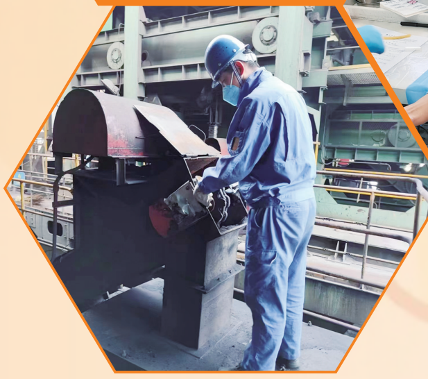
魏栋打开刮板机箱体进行链条检查。
