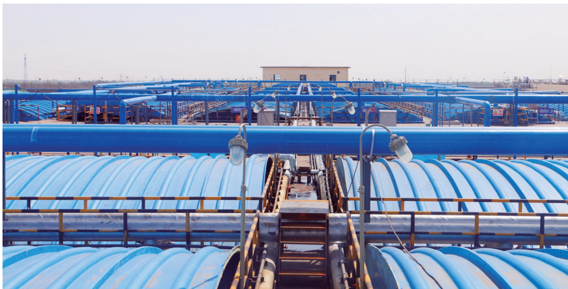
为切实降低寒冷、冰冻、降雪天气对废水处理系统的影响,宏兴股份公司焦化厂一化作业区酚氨废水站高效统筹疫情防控和废水处理系统稳定运行工作,组织开展重点场所、重要设施防寒保温工作,确保各类设备安全过冬、环保设施正常运行。 张静 张文学 摄
