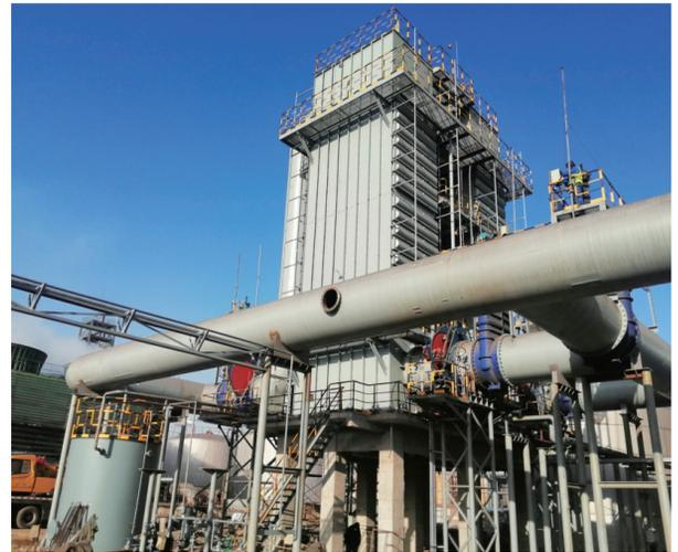
宏兴股份公司焦化厂1—4号焦炉煤气净化系统优化改造项目自今年2月份启动以来,项目组与施工单位、监理单位共同制定详细的施工工期横道图,挂图督办,按日分解,定期考评,圆满完成了1号脱硫再生系统、煤气预冷系统等全年施工任务。该项目投产后,将有效解决环境污染问题,进一步减少煤气脱硫系统停工检修对生产的影响。图为已建成交工的煤气预冷塔。
