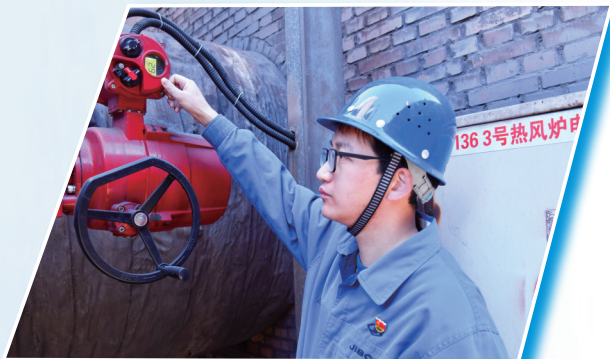
寇福明监测热风炉电动蝶阀数据。谭畅 摄
