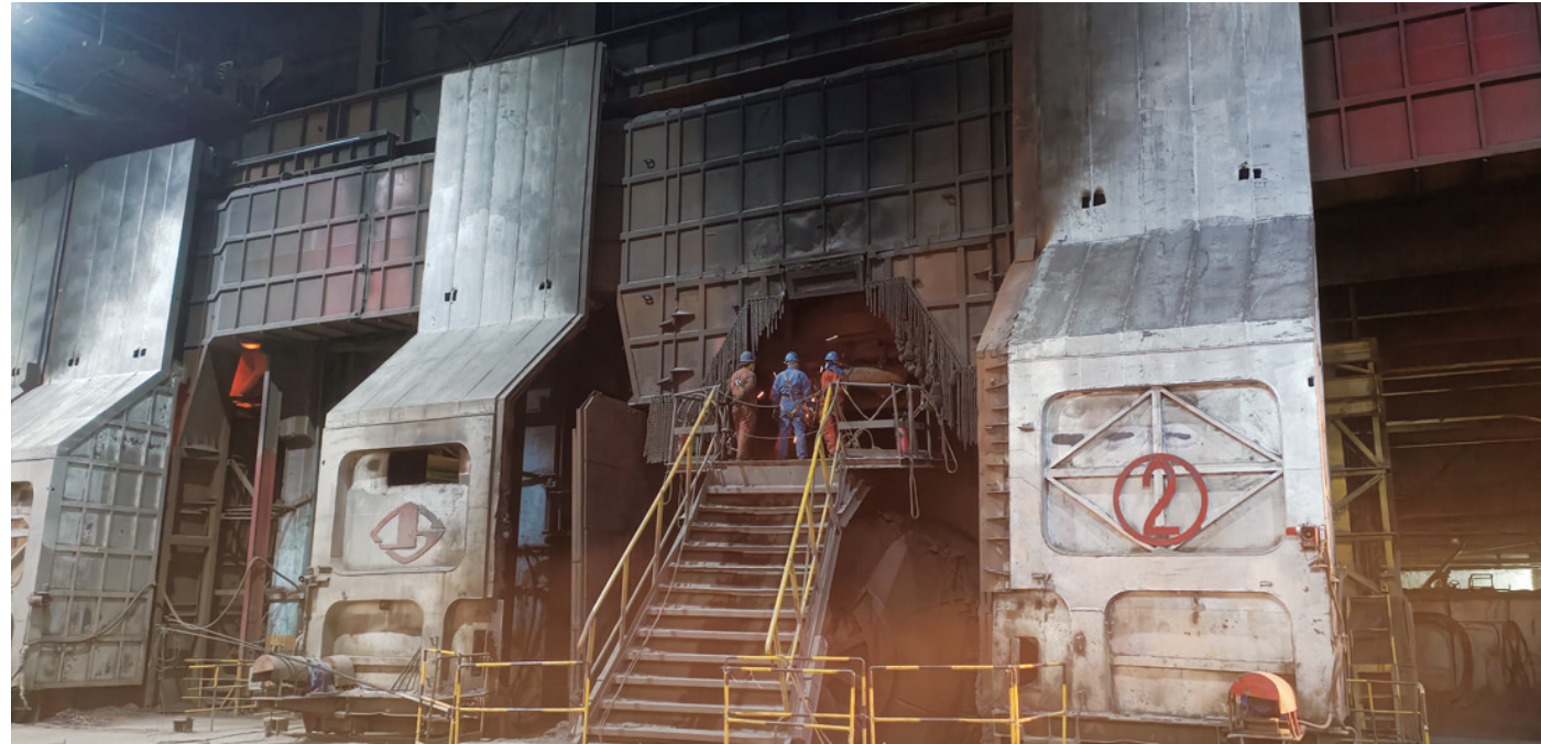
宏兴股份炼轧厂炼钢50T转炉烟道焊接时,人员直接爬上炉后搭设的铁质梯子,上到转炉托圈上作业,由于转炉温度(80-90℃)过高,且转炉托圈上搭设的铝合金梯子不好固定,人员在烟道内只能短时间作业,安全系数不高。日前,检修工程部炼轧检修作业区制作了烟道焊接专用平台,人员可较长时间作业,提升了检修安全保障。
