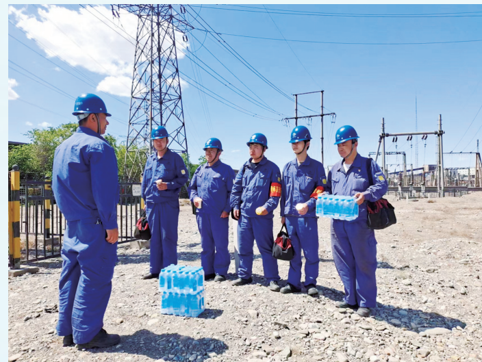
在宏晟电热供电分公司110kV汇集变电站区域光缆检修现场,一瓶瓶矿泉水和防暑降温药品的送达,让在场职工感受到了组织的关怀,也感受到了烈日炎炎下的一丝清凉。贺艳 摄
