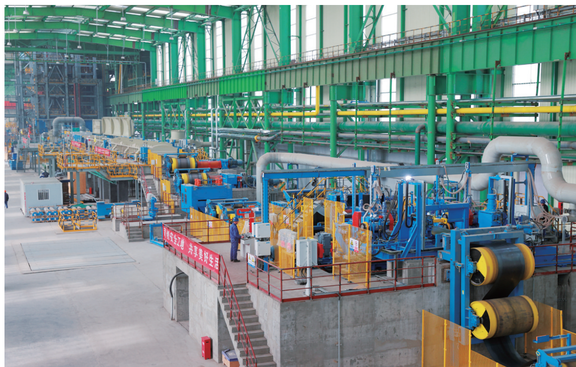
碳钢板厂热轧洗板(2.5—6mm)镀锌铝镁联合机组项目。
