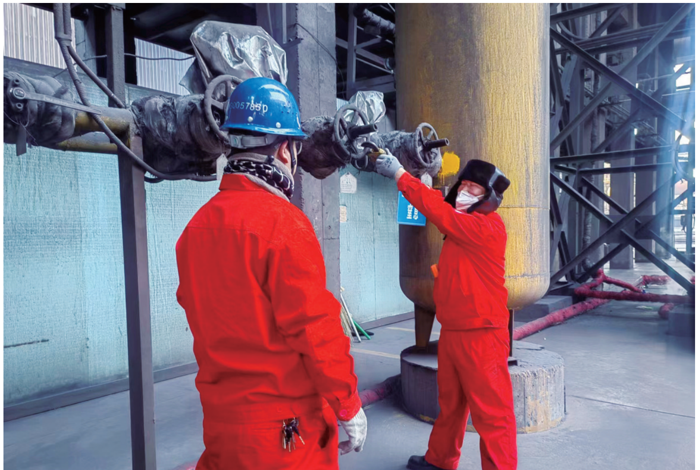
近期,宏兴股份公司检修工程部炉窑检修作业区开展了高炉热风系统设备检修维护工作。检修人员对热风炉关键设备进行清洁和润滑,对各类阀门及传动装置进行了调试和校准。此次维护不仅提高了热风系统设备的可靠性,还为后续的生产运行提供了有力保障。魏嘉雄 摄
