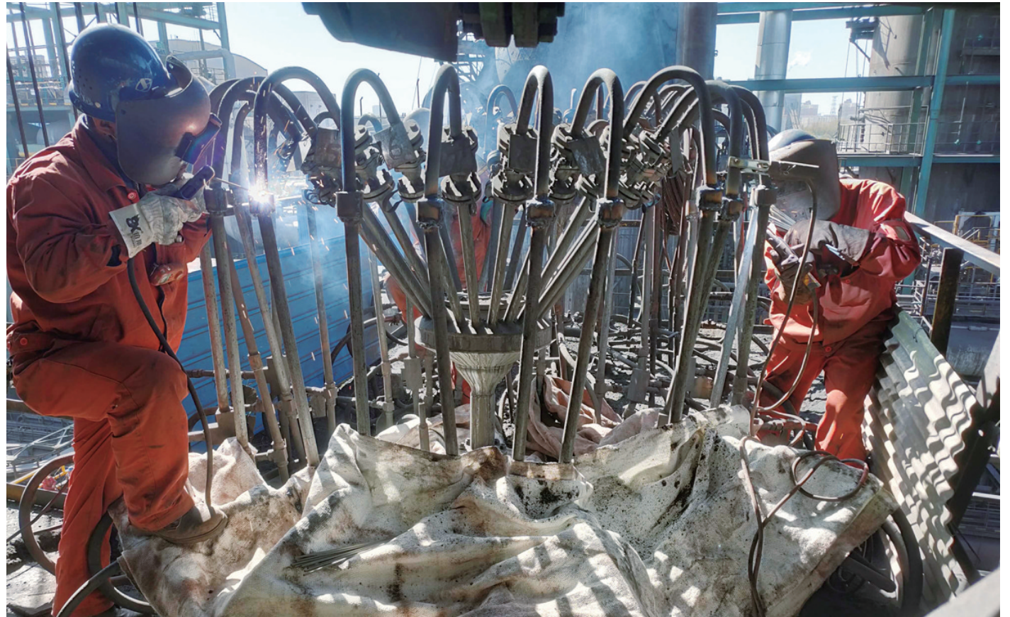
近期,宏兴股份公司检修工程部碳钢检修作业区主动联系各生产厂矿,在完成现有工作任务的基础上,承接了动力厂给排木一作业区200万转炉炉渣板沉淀池回水管敷设外部项目,创收13万元。朱海洋 摄
