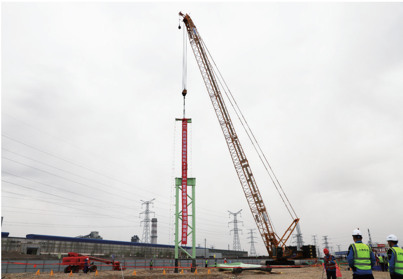
4月18日上午,炼轧厂工艺装备提升及产品结构调整项目4200mm宽厚板单项工程首根钢结构顺利完成吊装,标志着4200mm宽厚板单项工程由地下土建施工转为地上钢结构施工,为保质保量完成项目节点任务奠定了基础。
