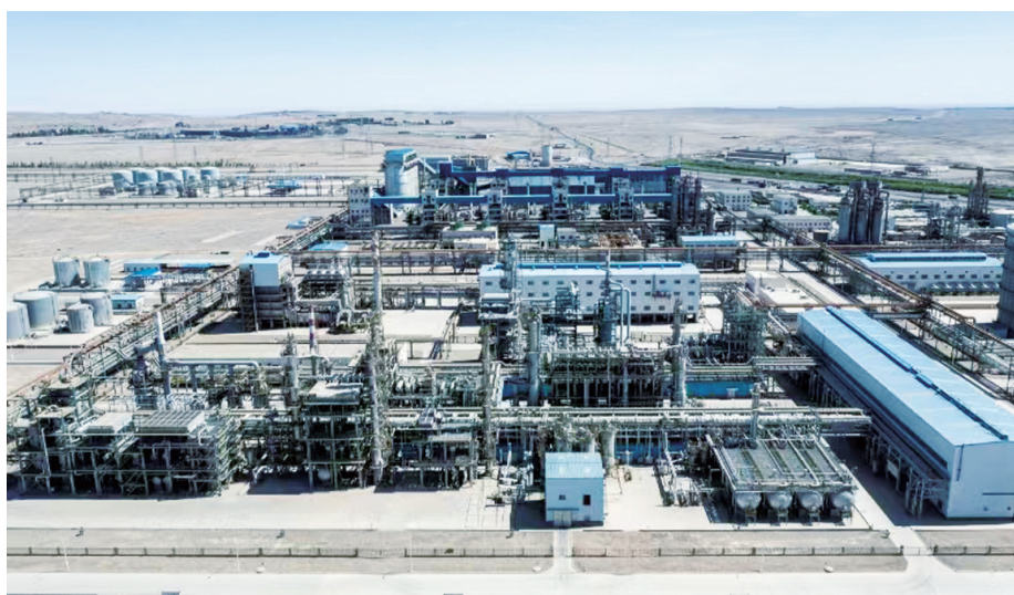
5月24日上午，酒钢集团宏汇公司1000万吨煤炭分质利用项目一期工程——150万吨煤炭分质利用项目全线投产。张秦阳 摄
