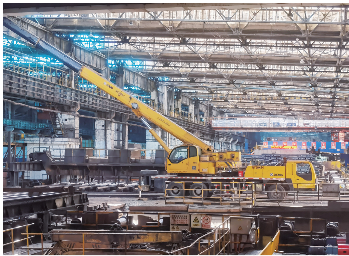
近日,宏兴股份炼铁厂组织开展计划60小时的炼钢系统全停检修,涉及天车公辅、电机设备等170余项检修项目。该厂围绕检修质量、施工队伍、安全环保等方面制定详细方案,高标准、严要求推进检修任务,确保全停检修圆满完成,为炼铁厂二季度高产稳产奠定坚实基础。摆永萍 摄
