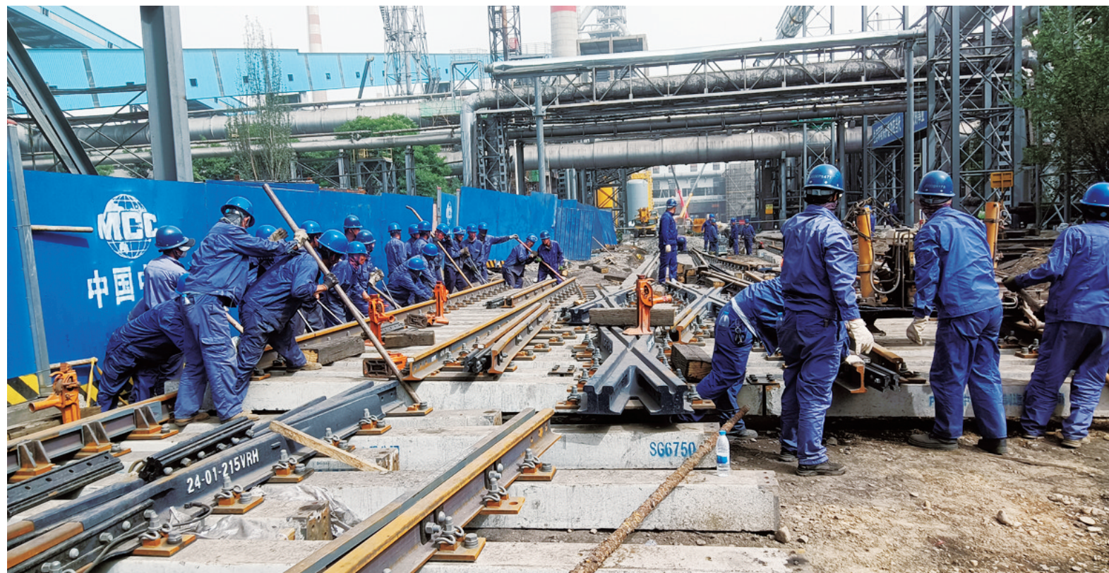
近日,物流机电作业区圆满完成2号高炉南侧318号、320号、322号道岔更换道砟任务,提升设备运行水平,减少后期维修成本,确保安全稳定行车。 张占坡 摄
