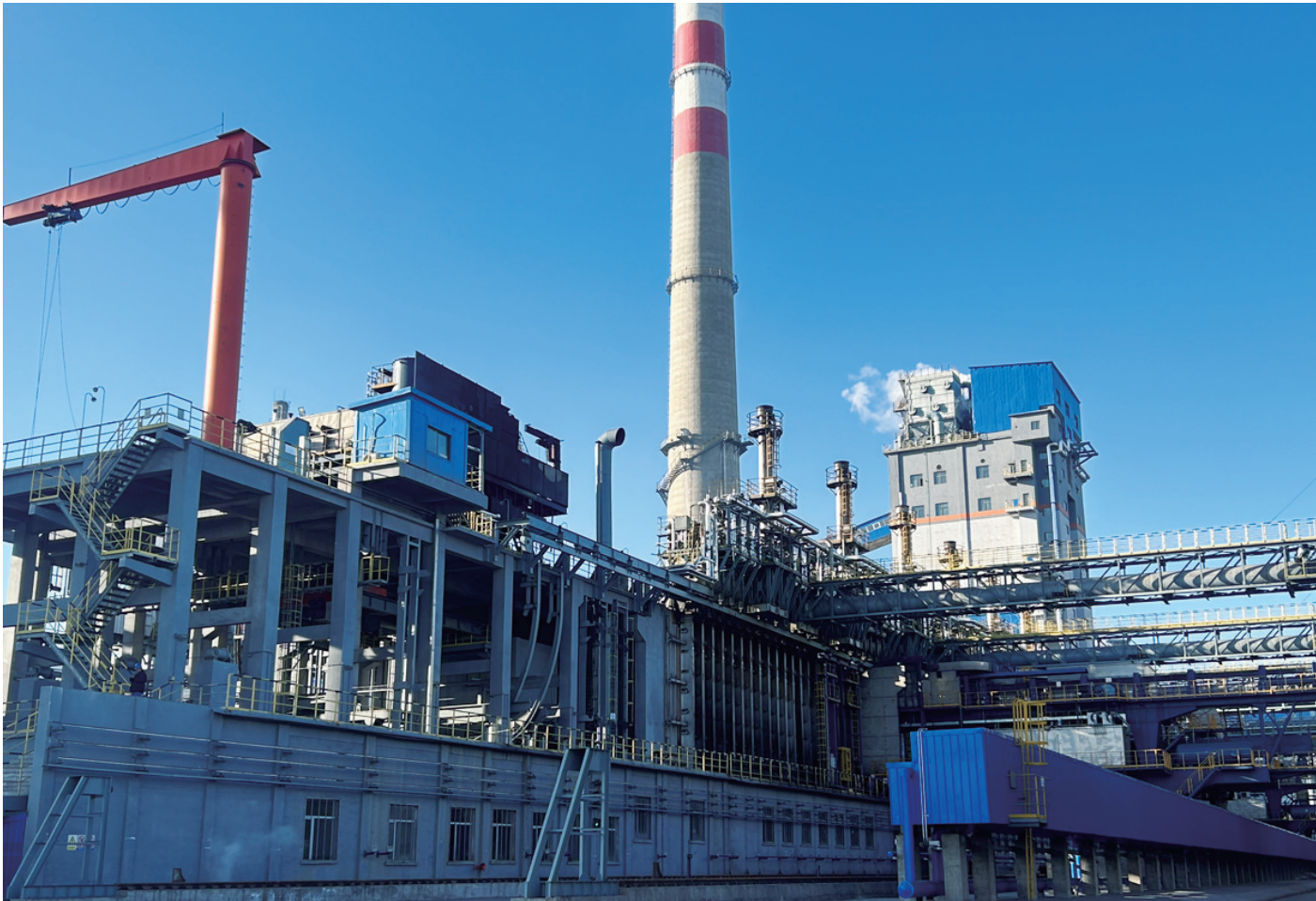
5月份,宏兴股份宏能能源公司牢固树立上下“一盘棋”思想,紧盯生产经营目标任务,高效统筹采购、运输、仓储、配料、生产组织、系统检修等各个环节,多项生产经营指标取得进步。其中,焦炭成本、吨焦耗湿煤分别较计划下降56.3元/吨、0.6千克/吨。图为1号2号焦炉生产现场。张静 摄
