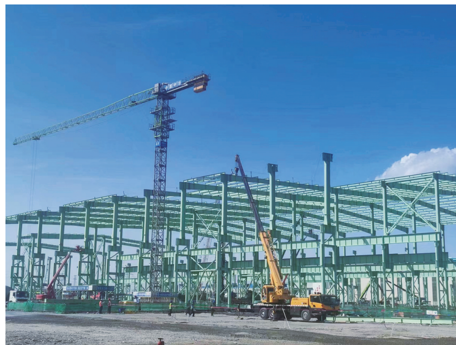
6月份以来,东兴股份炼轧厂工艺装备提升及产品结构调整项目积极落实“安全生产月”各项措施,切实抓好安全工作,全力推动项目建设提速增效。截至目前,该项目炼钢连铸厂房钢结构完成30%,4200mm宽厚板单项工程厂房柱安装完成总进度的46%。
