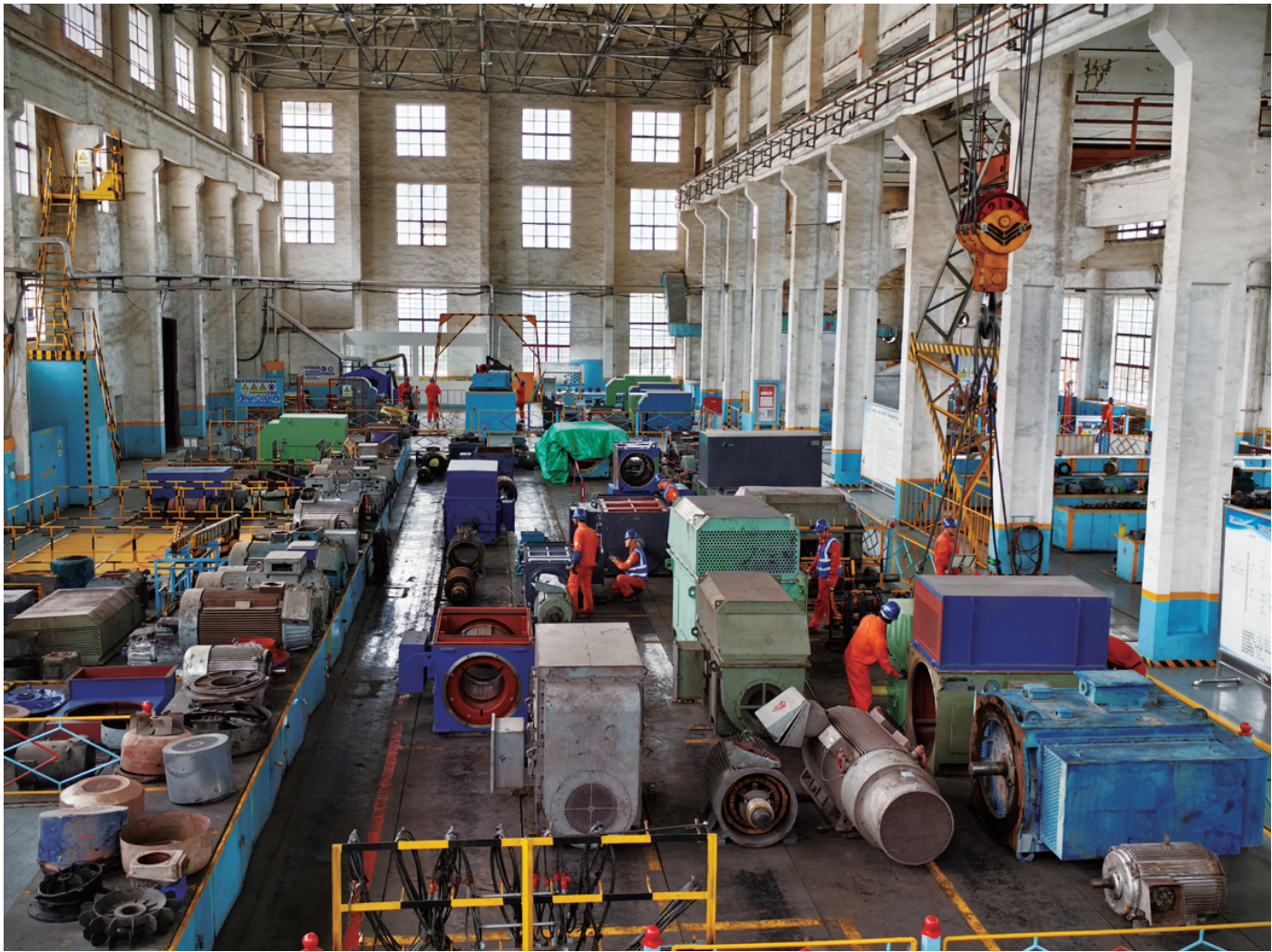
▲近日,宏兴股份检修工程部电器修造作业区克服高温天气,合理分配人力,利用检修基地试验与现场检测相结合的方式,保证各项电机上线质量与工期进度。
