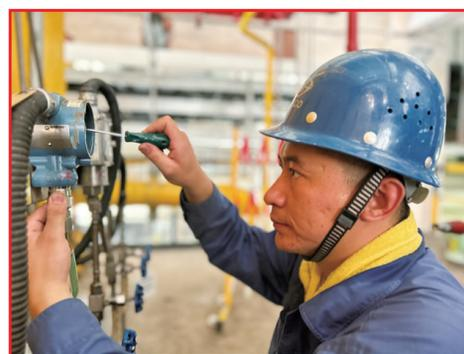
炎炎夏日,宏晟电热公司电仪检修作业区热控检修人员顶着铝电4号机组厂房内40摄氏度的高温,检查更换100多台变频器板件、传感器以及其他损坏或老化的部件,全力以赴保证机组检修后长周期安全稳定运行。许娇 摄
