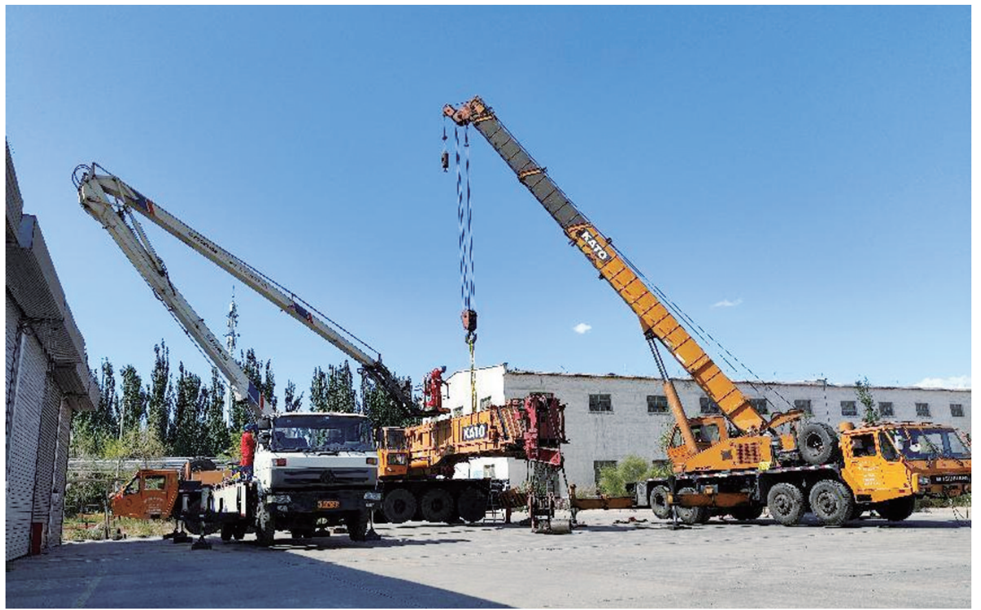
近日,宏兴股份检修工程部设备检修保障作业区开展车辆隐患排查,重点对吊车发动机、中心回转机构、起升限位等进行隐患排查。7月份,共排查整改车辆隐患31项,确保了车辆性能完好、运行可靠,助力宏兴股份公司设备检修工作有序进行。 王永祥 摄
