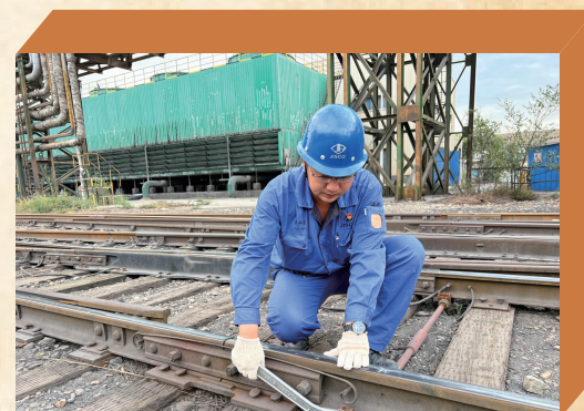
张永吉紧固轨距杆螺栓
