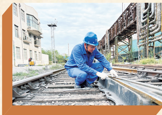
张永吉检查道岔裂纹情况
