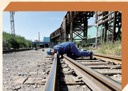
张永吉检查道岔高低情况
