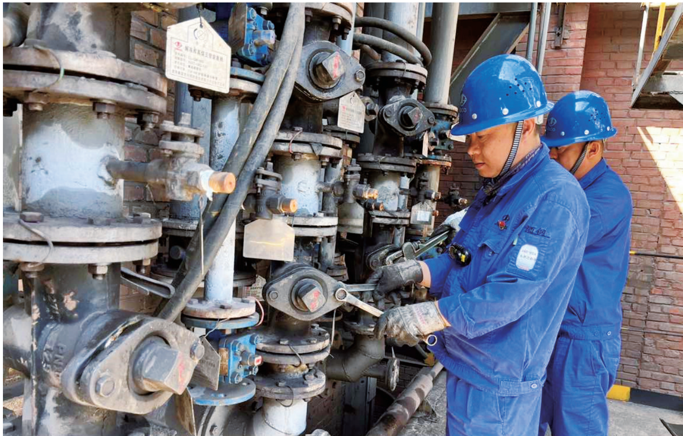
近期,物流公司车辆作业区重点对嘉北站4座解冻库电机、阀门、管路和煤气水封等设备设施进行维修保养,确保冬季解冻工作平稳有序。截至目前,共检修引风机14台、110kW电机14台、更换阀门100余个。
