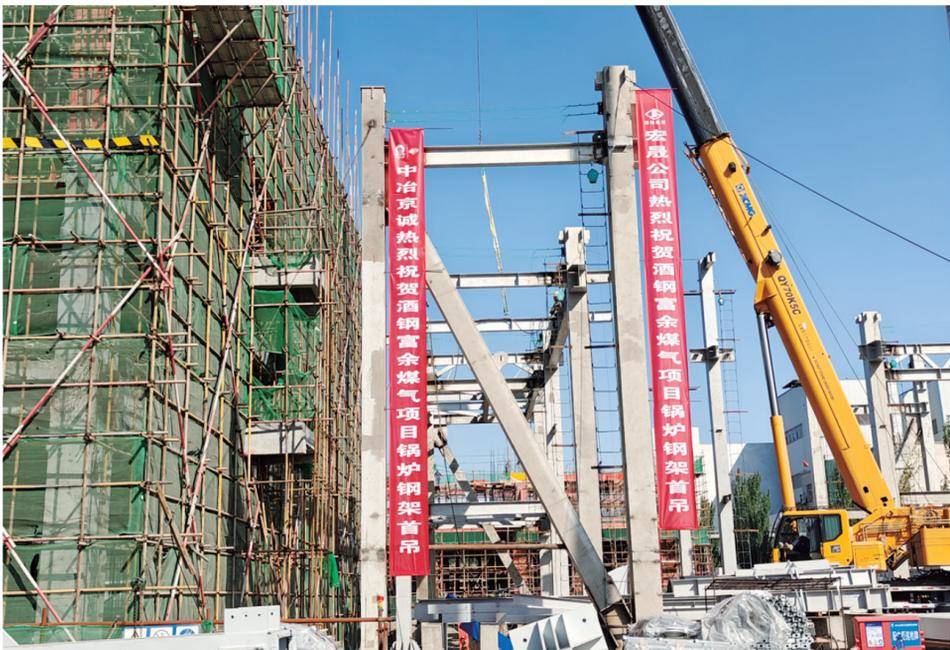
近日,酒钢富余煤气综合利用节能降碳项目锅炉钢架开始吊装,标志着项目建设正式进入主体安装阶段。该项目锅炉为1X210t/h超高温亚临界锅炉,共有21根立柱钢架,建成后年可供电量4.23亿千瓦时、节约标准煤13.29万吨,助力集团公司煤气资源循环高效利用。
