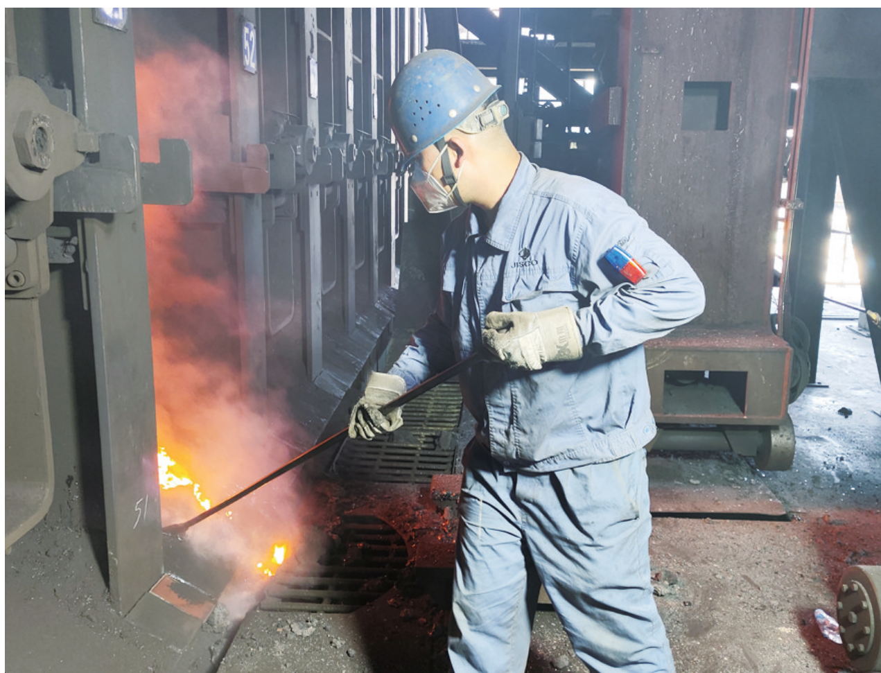
▲面对严峻“考验”,宏晟股份宏翔能源公司确保出一炉、扫一炉、清一炉、灭一炉,精细化处理炉门刀边严密度,保障每炉焦炭高质量推出。图为炉门工清理炭化室底部积料和炉门框积料。 陈建强 摄
