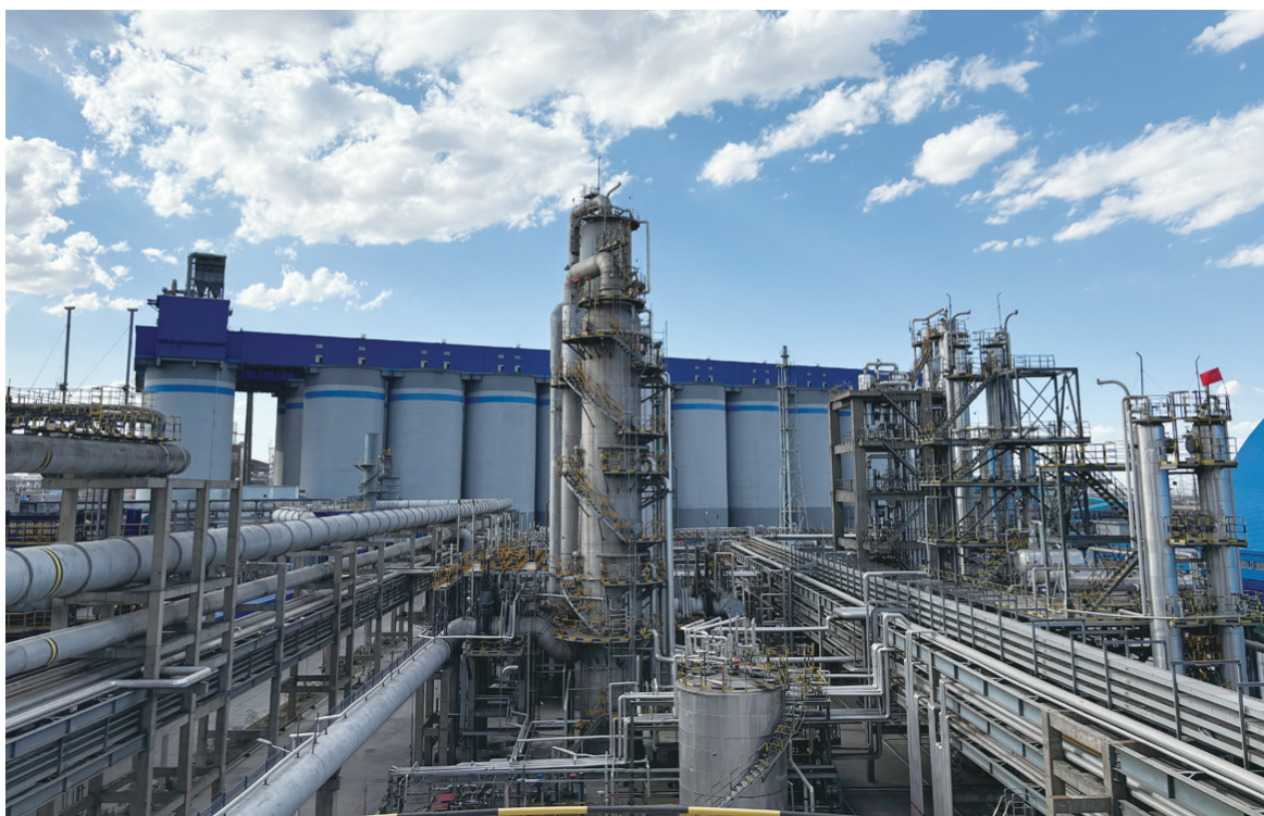
近日,宏兴股份宏翔能源公司完成化产液氨区域氨塔捕雾层优化改造,提高氨塔捕雾层冲洗效果,降低氨塔阻力,为保障液氨质量稳定和安全生产工序运行奠定了坚实基础。张霞霞 摄
