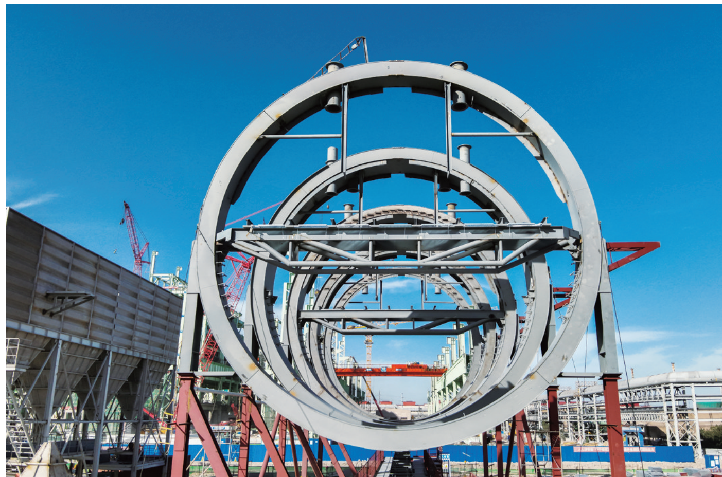
近日,宏兴股份炼铁厂工艺装备提升及产品结构调整项目炼钢连铸单炉2号转炉静电除尘器环梁完成全部吊装,标志着该项目静电除尘系统设备安装工作已全面展开。 郭俊 摄
