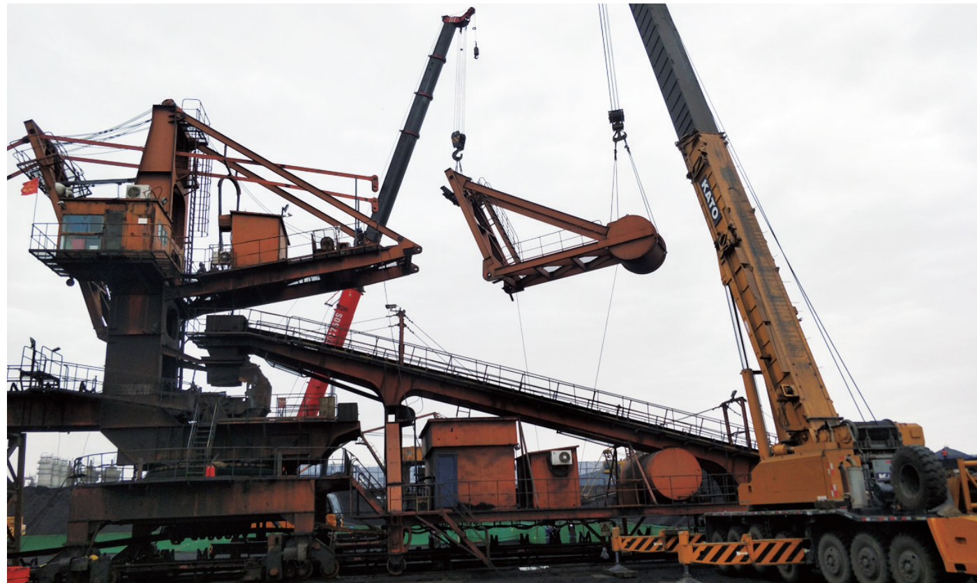
▲宏基股份检修工程部设备检修保障作业区积极响应降本增效号召,8月份,通过废旧物资回收创收20.55万元,实现成本压降工作顺利开展。 肖龙龙 摄
