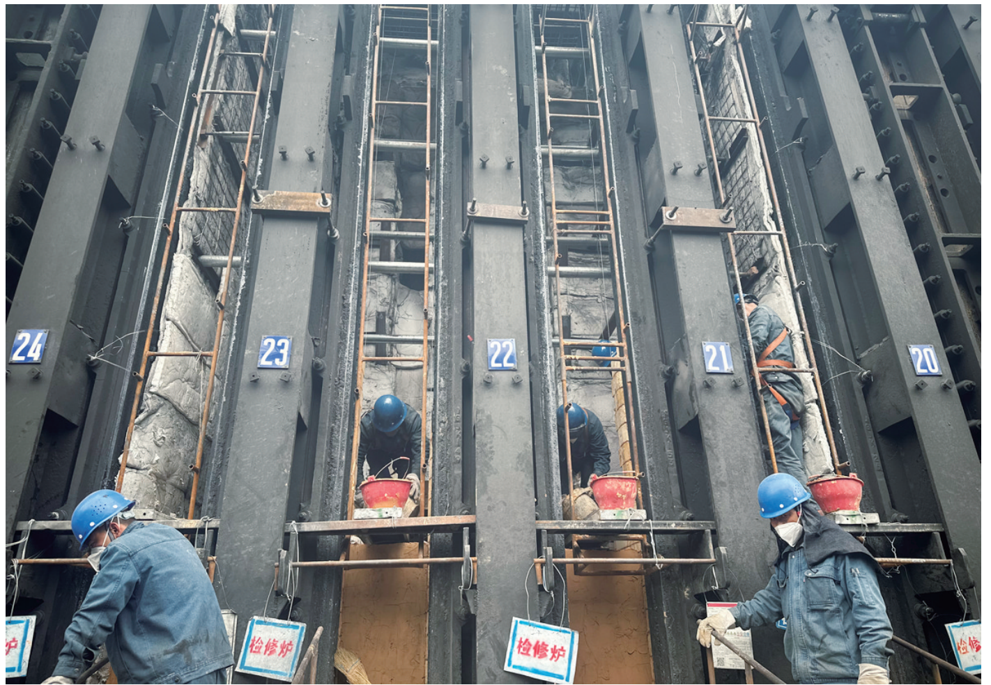
近日,宏兴股份宏翔能源公司二炼焦作业区组织开展3号4号焦炉维修工作,解决了老焦炉推焦电流大、炉墙窜漏严重等问题,延长了焦炉使用寿命。目前,3号4号焦炉已分别稳定运行27年、18年。
