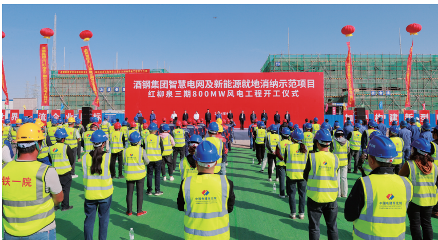
玉门红柳泉三期800MW风电工程开工仪式现场。张志方 摄
