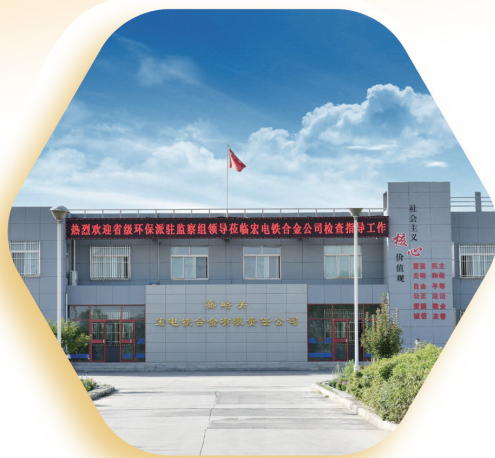
宏电铁合金公司办公楼
