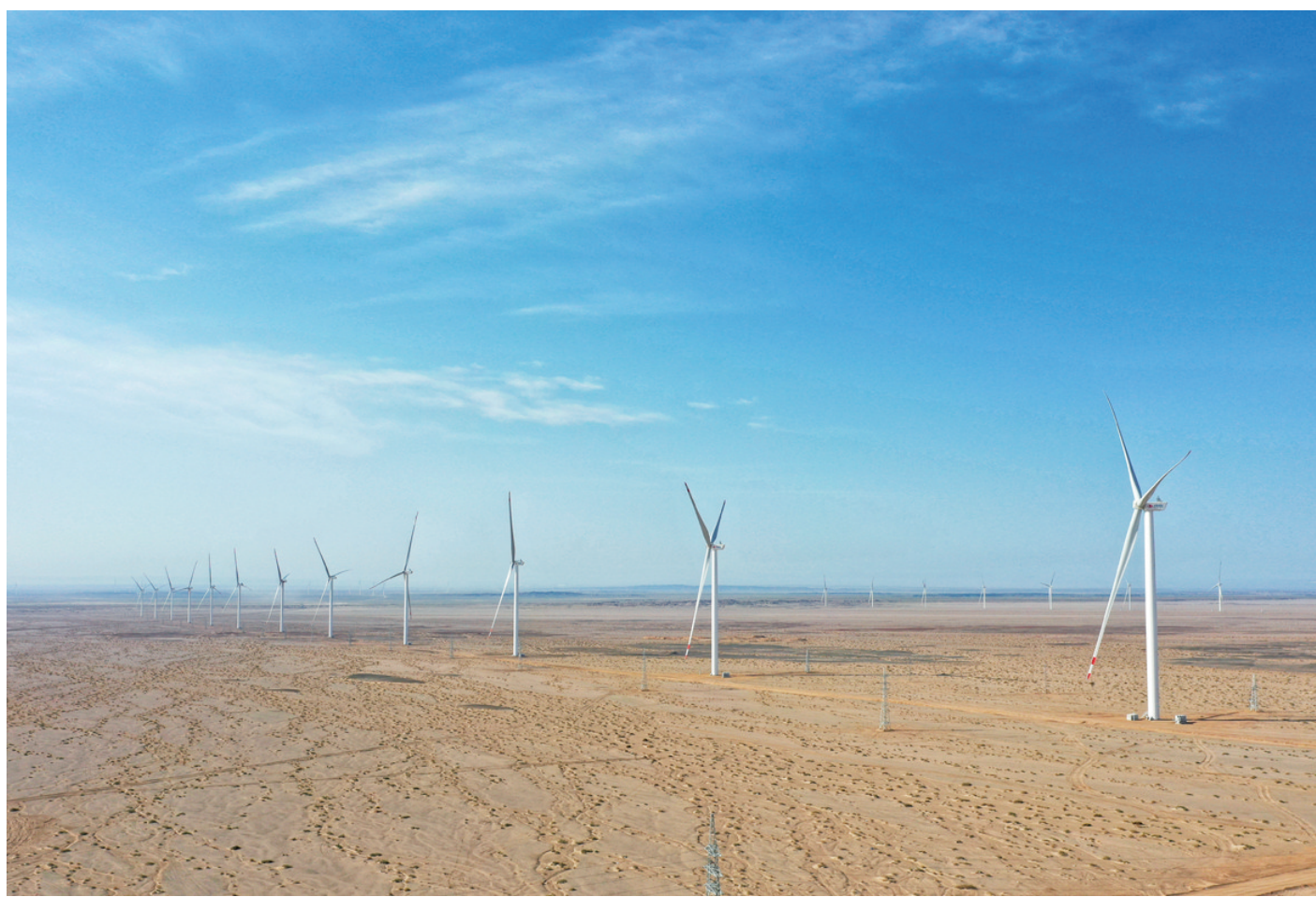
酒钢集团智慧电网及新能源就地消纳示范项目玉门红柳泉一期200MW风电项目自投产运行以来,项目部全体成员全力做好运维人员培训、风功率预测、生产指标分析及设备运维等工作,确保了风力发电机组安全、高效、稳定运行,为集团公司持续推进绿色低碳转型发展贡献力量。
