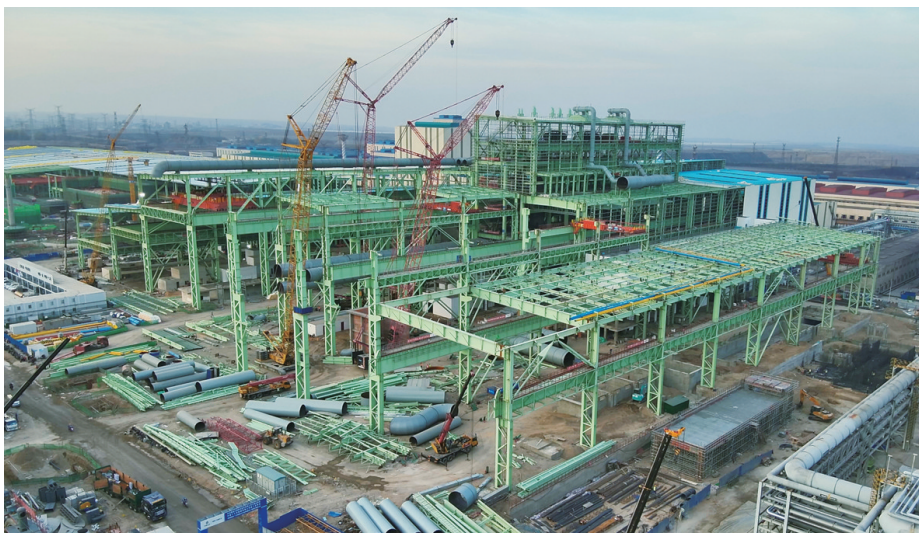
炼轧厂工艺装备提升及产品结构调整项目建设现场。谢希科 摄
