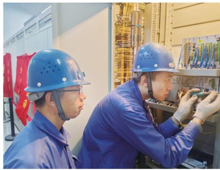
本报讯(通讯员 冯转转)近日,宏晟电热公司供电通信作业区顺利完成三总降变电站110kV二热自备线保护装置改造,实现了故障提前预警、快速定位等功能,进一步提升了电力保供设备运行的稳定性。
