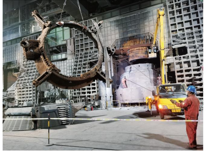
近日,宏兴股份检修工程部碳钢检修作业区提前1.5小时完成碳钢板厂3号转炉活动烟罩更换任务,检修人员用“严、慎、细、实”的工作要求保障生产,用专业的技术技能为生产经营贡献检修力量。 卯发奎 摄
