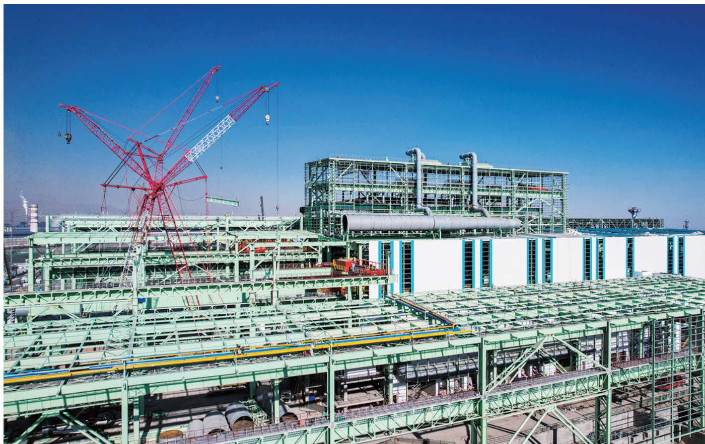
宏兴股份炼轧厂工艺装备提升及产品结构调整项目宽厚板单项工程、炼钢连铸单项工程正稳步推进。目前,1号转炉完成推炉,连铸区域屋面系统安装完成,宽厚板主厂房钢结构安装完成,为后续项目施工奠定了良好基础。 李淑芳 谢希科 摄
