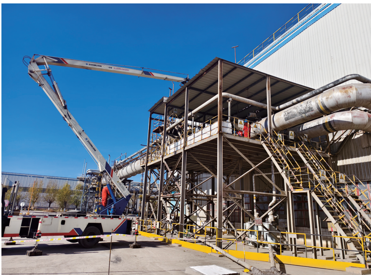
今年以来,宏兴股份检修工程部铁前检修作业区持续开展内部管理挖潜和外部业务拓展“两手抓”活动,生产经营指标全面“飘红”。1—10月份,该作业区检修工时完成年计划的119.45%,人均工时较2023年同比增加16.66%,保障费用同比降低14.57%。 安华凯 摄
