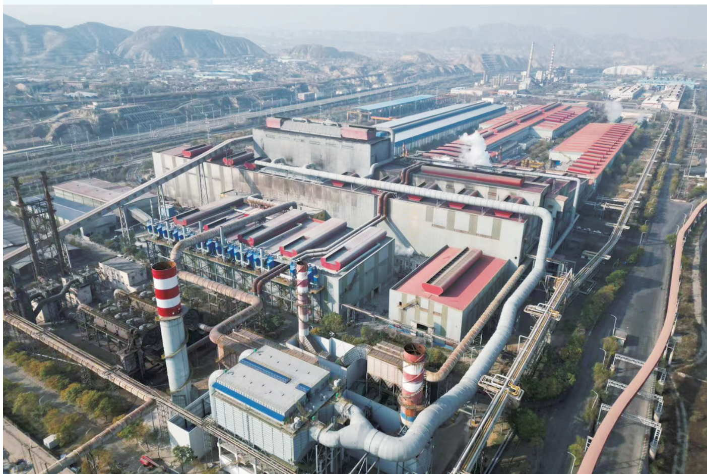
▼图为榆钢炼钢区域超低排放改造项目远景图。 安阳 摄
