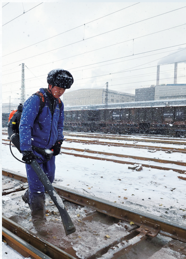
物流公司职工吹扫铁路道岔积雪。
