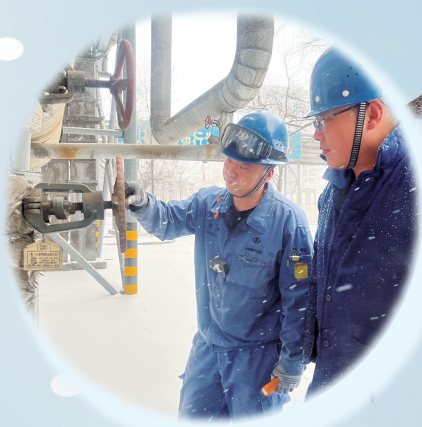
宏晟电热公司热力保障作业区职工检查热力站室外截止阀。
