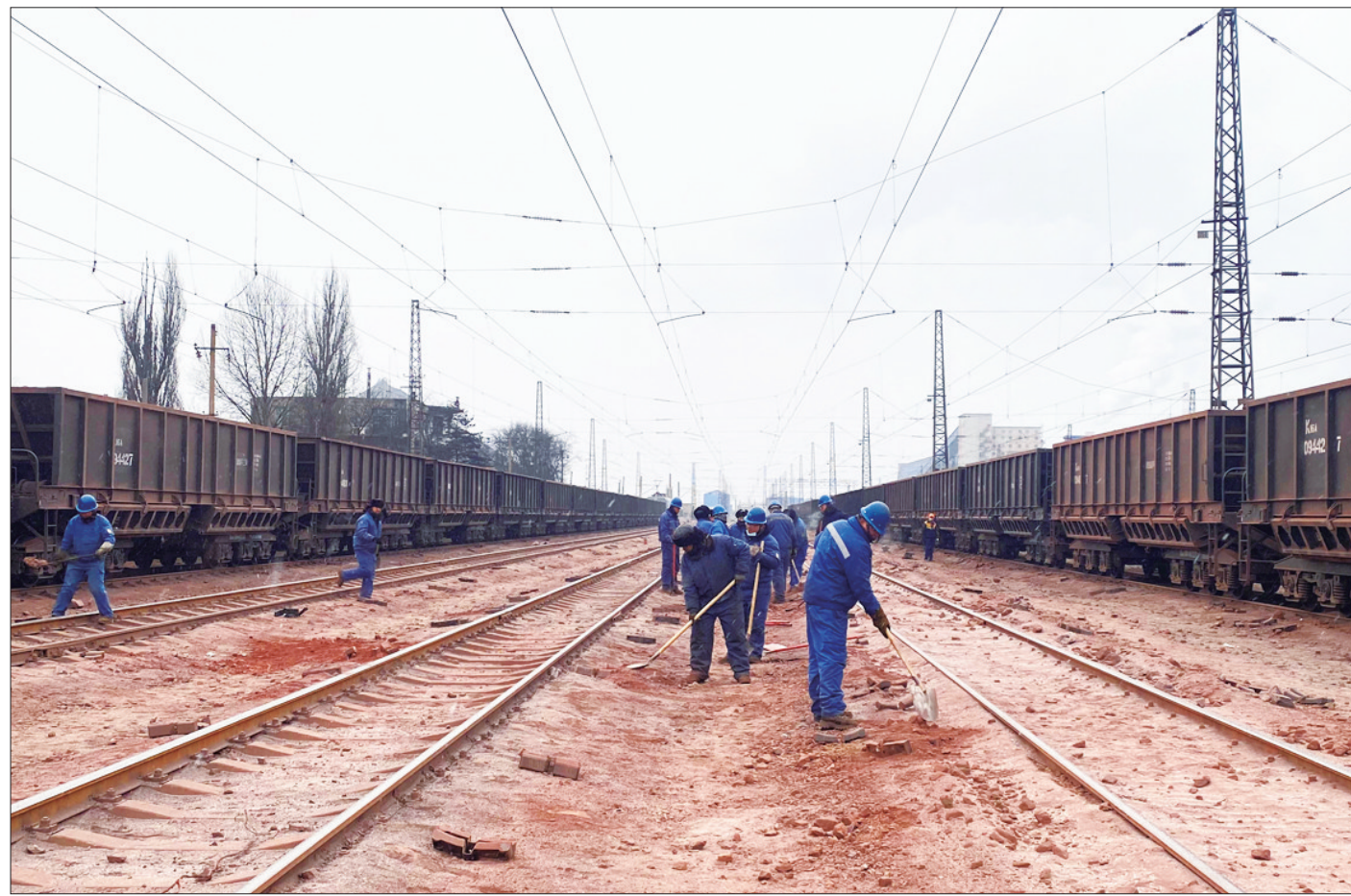
▲近日,物流公司嘉北运输作业区对翻车机落地物料和站内落地矿进行了清理,清理过程中,各班组划分责任区域,明确清理标准,100余名职工清理了嘉北站3500米线路间的落地矿,进一步改善了现场作业环境。 段位玺 摄
