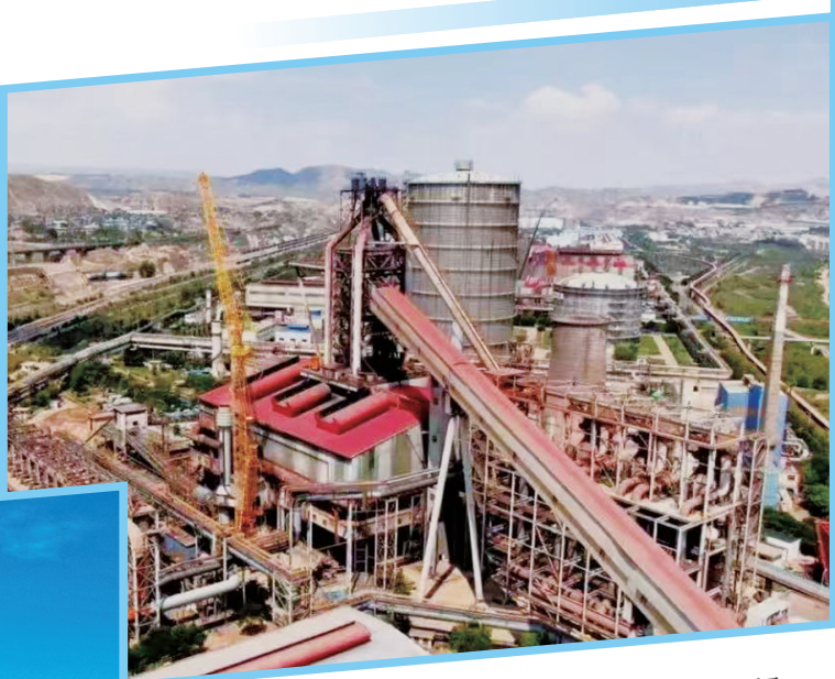
宏兴股份榆钢炼铁工艺装备优化改造项目。安阳 摄
