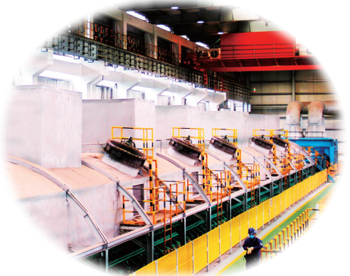
宏兴股份炼铁厂新1号烧结机。 郭忠山 摄
