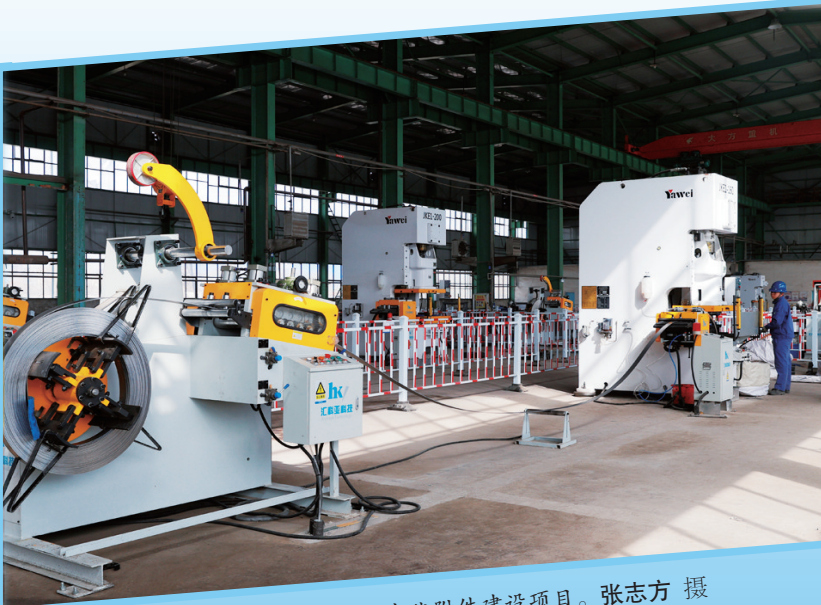
汇丰公司新能源产业基地光伏附件建设项目。 张志方 摄
