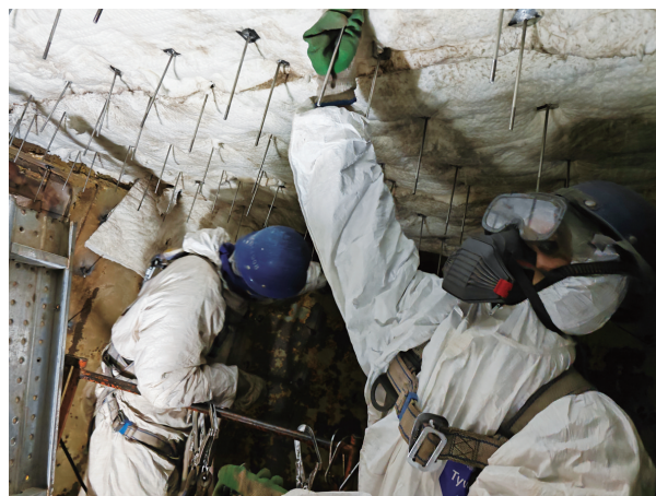
检修工程部炉窑检修作业区开展加热罩耐火材料修复。
