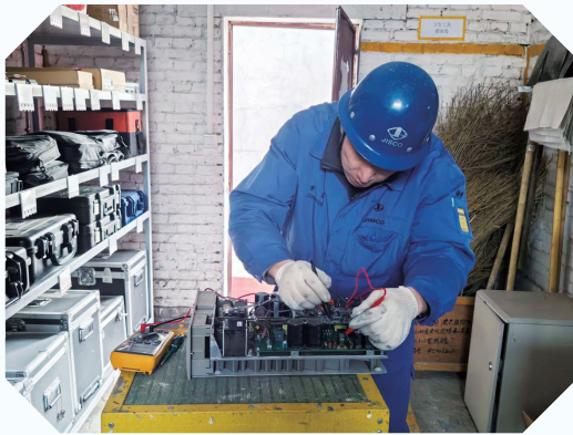
供电通信作业区职工维修设备。
