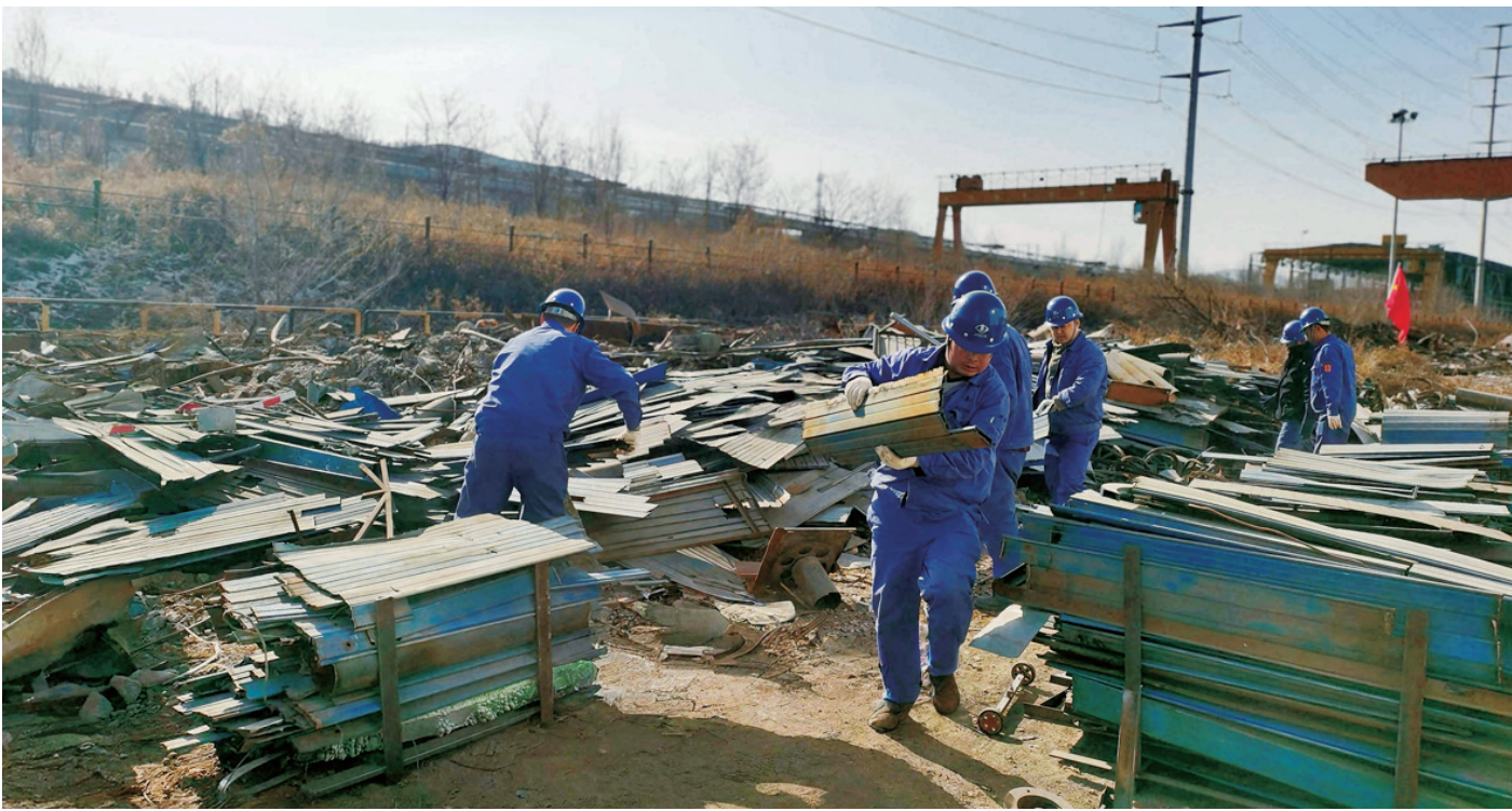
日前,工程技术公司兰州钢结构分公司党支部组织开展废钢清理行动。党员分组协作有序完成废钢分拣、码放及装运工作,以实际行动让料场环境焕然一新。李旭文 摄
