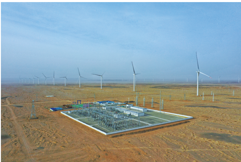
金塔白水泉一期200MW光伏发电项目。
