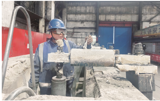
炼轧厂耐材作业区职工为横梁及护套刷涂层。
