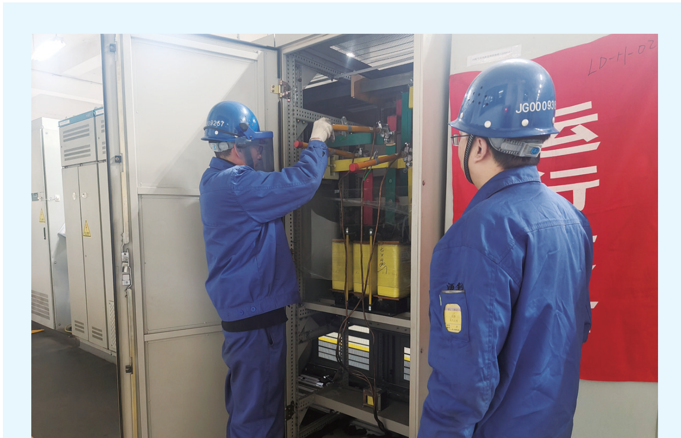
近日，宏兴股份炼轧厂大棒线作业区开展电气倒闸操作专项培训。电气工重点讲解“手指口述”动作要领、操作票规范填写、接地线安装等，并进行操作演示。此次培训进一步提升了职工的操作技能，为安全生产提供了有利保障。
