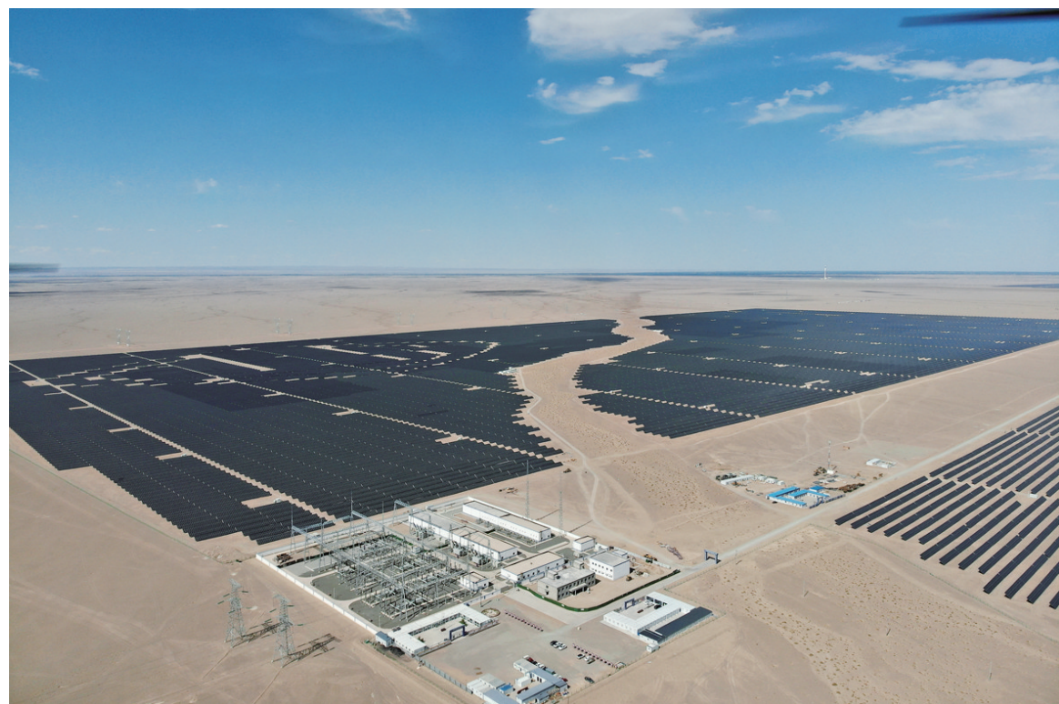
酒钢智慧电网及新能源就地消纳示范项目金塔白泉水二期400MW光伏工程自并网发电以来,宏兴热电公司强化设备精细运维,优化生产经营组织,促使工程实现了安全、稳定、高效运行。该工程预计年均上网电量约7.7亿kWh,每年可减少碳排放约64万吨。
